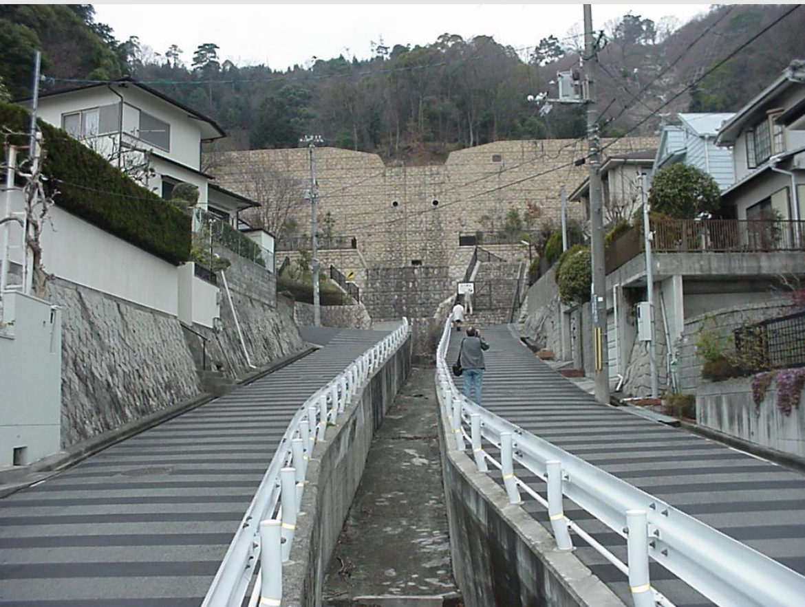
Presilla cerrada, de concreto armado, rodeada de casas residenciales al comienzo de la zona urbana del Río Sumiyoshi, en Kobe.
